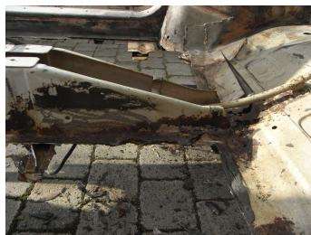
(a) Fahrzeugtunnel mit bereits entfernten Bodenblechen.
