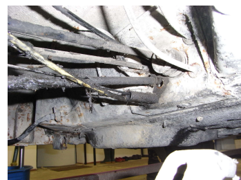
(f) Sämtliche Leitungen, Seile, Kabel, Gelenke waren nicht mehr brauchbar.
