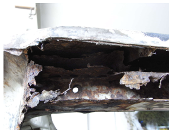
(b) Mehrfach wurden Blechteile aufeinander geschweißt oder genietet und kiloweise mit Spachtelmasse verschmiert.
